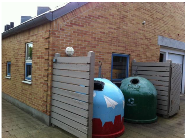
En påsat brand i disse containere vil med overvejende sandsynlighed føre til brandspredning til den tilstødende bygning. Foto: Nordjyllands Beredskab
