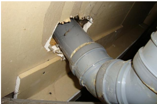
Når en gipskonstruktion gennembrydes og et plasticrør som her føres igennem, fjernes den brandbeskyttende effekt.
